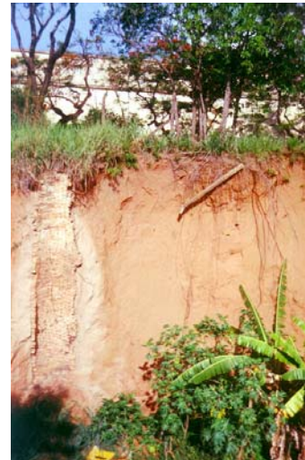
Figura 04- Aspectos degradantes da boçoroca da Vila Industrial
