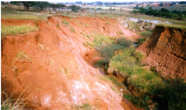
Figura 07- Pousada da Esperança I: aspectos degradantes ambientais dessa boçoroca.
